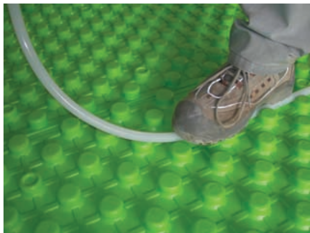
upevnění trubky k desce s výstupky
