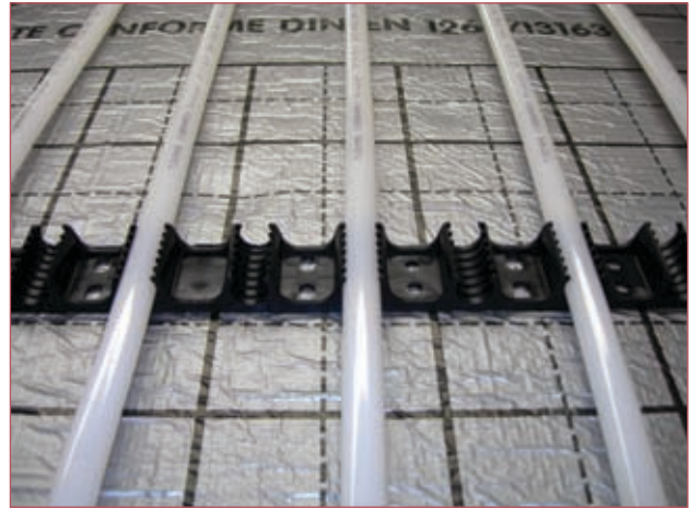
upevnění trubky pomocí uchytcovacích lišt
