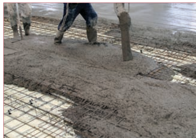
pokládání betonové výplně v průmyslové budově
